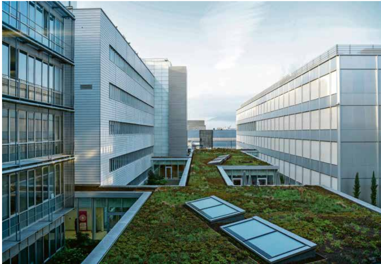
Le nouveau campus de Firmenich, en banlieue de Genève, a nécessité un investissement total de près de 200 millions de francs. (FIRMENICH)
